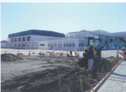
工事中の東城南小学校
